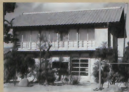
② 蒲田へ移築後の外観。
